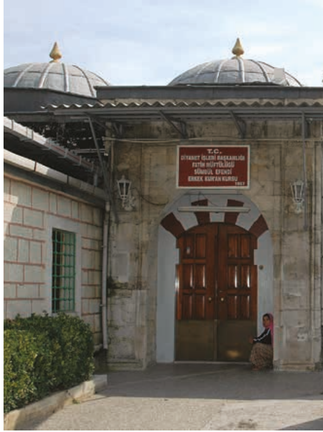
Sekil 50 Medresenin giriş cephesi.
