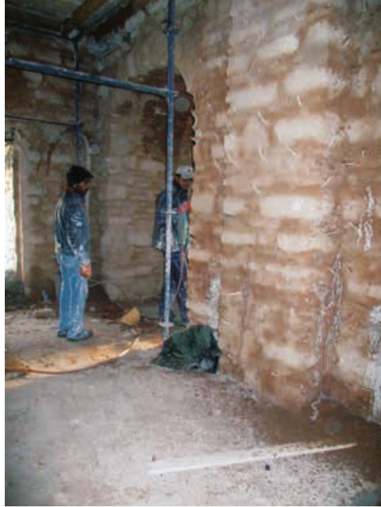
Şekil 14 Cami duvar içindeki boşlukların doldurulması.
