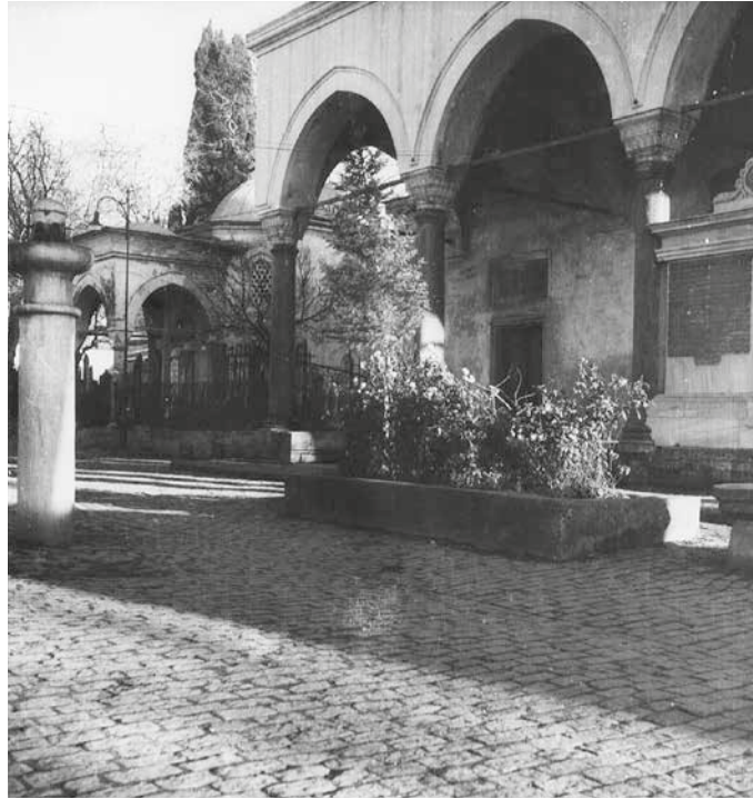
Şekil 123 Kuş Çeşmesi, giriş cephesi ve avlu döşemesi.
