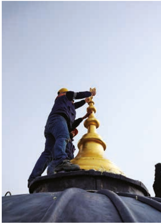
Şekil 7 Alemin, yerine monte edilmesi ve genel görünüşler.
