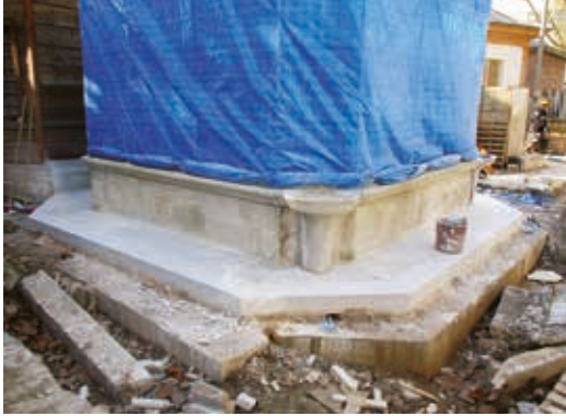
Şekil 39 Türbenin mermer kaidesindeki eksik parçaların yerine yeni parçaların ankre edilmesi.
