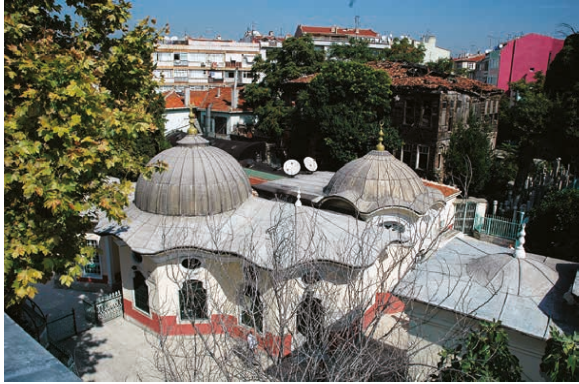
Şekil 12 Restorasyon öncesi türbelerden genel görünüş.
