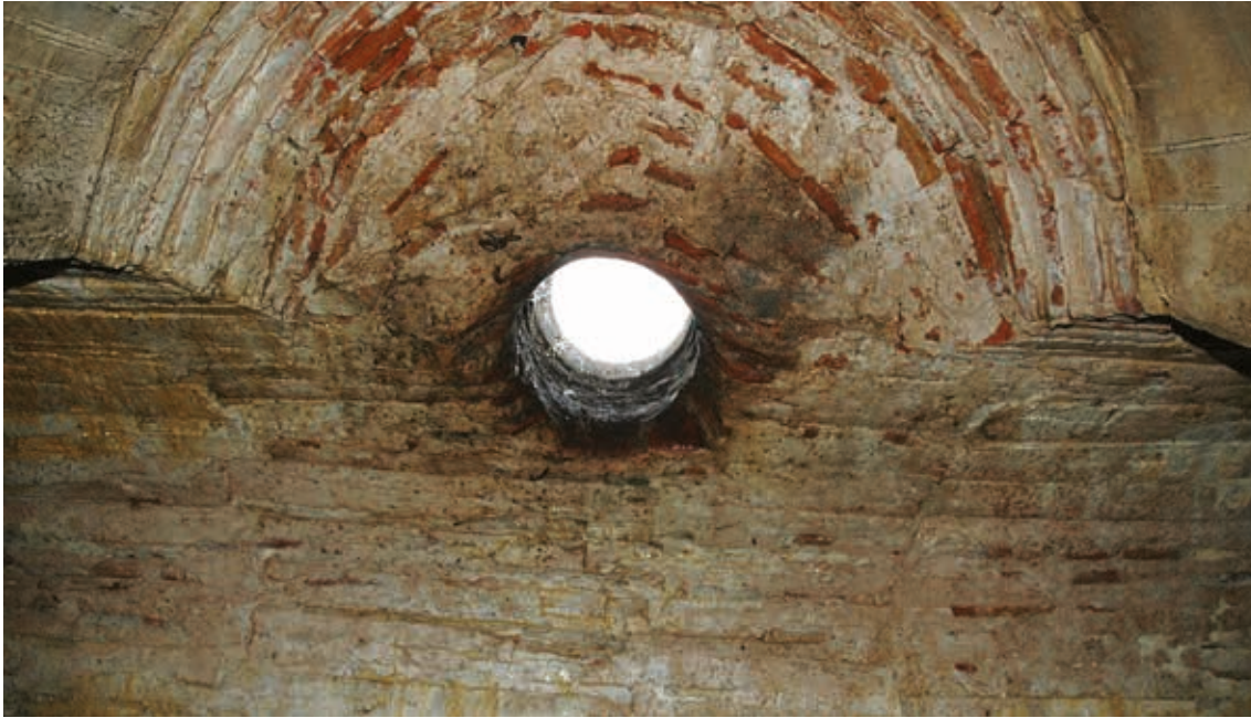
Sekil 47 Üst örtüye açılan delik.
