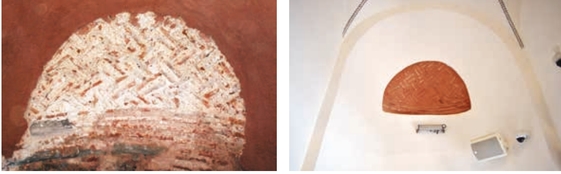
Sekil 19 Diakonikon yarım kubbesinin içindeki dekoratif tuğla düzenlemesinin, derz çalışması sırasında ve sonrasında görünüşleri.
